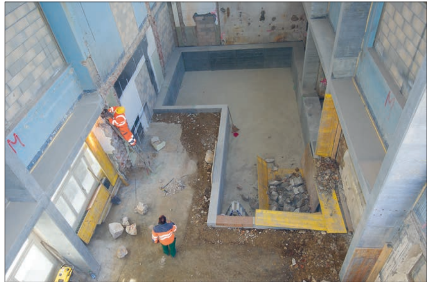
Espace sur trois étages d'usine : de la place pour un trampoline en fosse et un bac à mousse de réception.
